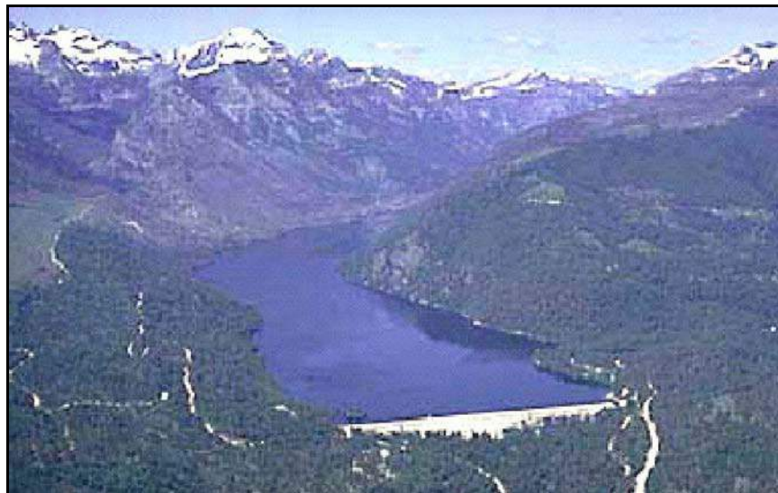
Figure B-33. —Aerial view of Como Dam, Montana.
